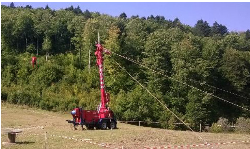
Instalarea unui funicular
